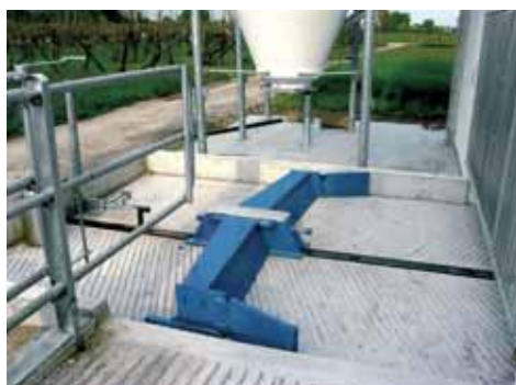
Raschiatore a ribaltella nella zona di sosta.
