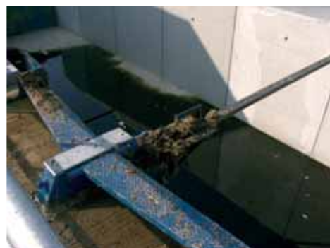
Raschiatore a ribaltella in fase di scarico in vasca.
