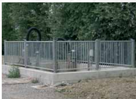
Recinzione per vasca liquami.
